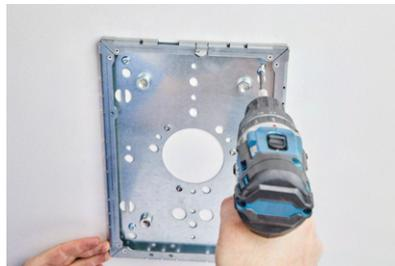
Bestimmen und markieren Sie die zu bohrenden Stellen. Verwenden Sie einen Bleistift oder Marker. Bohren Sie die markierten Stellen und bereiten Sie sie für die Schrauben vor.
