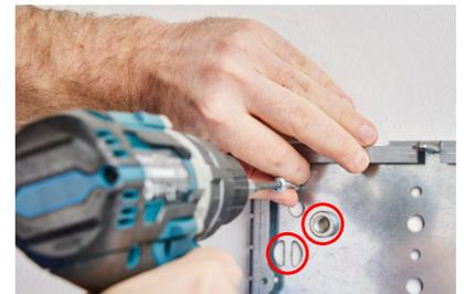
Aufhängung an der Decke mit Hilfe der Halterung:
