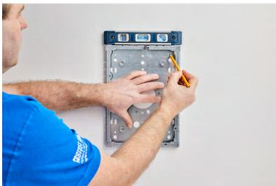
Wählen Sie die passenden Befestigungslöcher je nachdem, ob es sich um eine ebene oder unebene Fläche handelt oder ob es an einem Balken befestigt werden soll.
